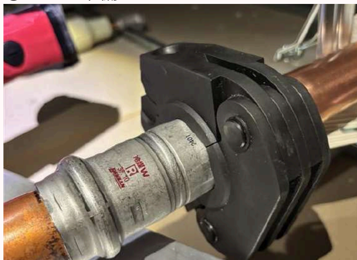
継手にプレスリングを装着
