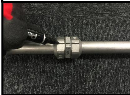
施工後の共回りや振動などによる袋ナットの緩みを目視確認するため、継手全体軸方向にマジックなどでチェックラインを入れます。
