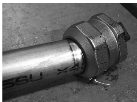
写真－4 水圧破壊状況
