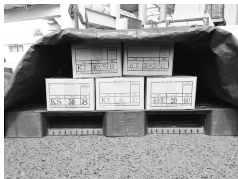
袋開封後防塵対策養生
