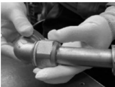
④ BKジョイントⅡの継手本体に「変換ナット」を手締めし、その後パイプレンチで本締めを行います。
